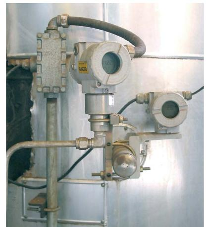
Os conversores são utilizados para realizar a comunicação entre os sinais convencionais (0-20 mA, 4-20 mA) com os sistemas de automação digital em tecnologias de comunicação FOUNDATION™ fieldbus ou PROFIBUS-PA.
