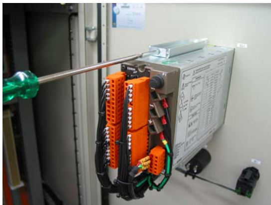
Figura 2 – Chave de Fenda sobre o Parafuso da Presilha do CD600 Plus
