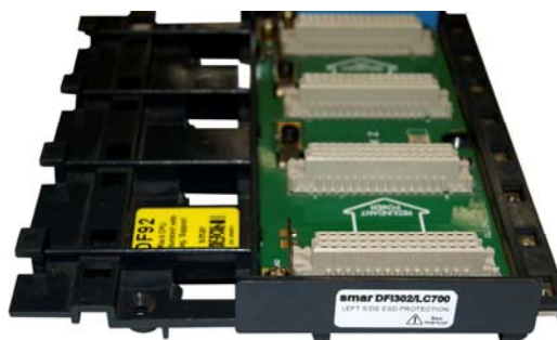
Figura 3. 5 – Protetor lateral esquerdo instalado no rack
