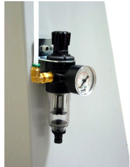
Figura 1.31 - Detalhe do Filtro de Ar
